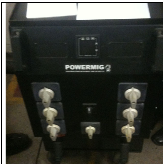
Figura 2 – Banco de Carga PM 6500
